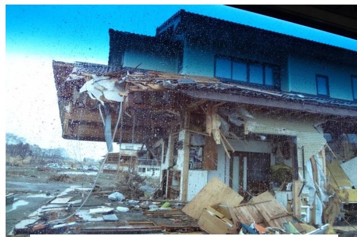
津波で一階が破壊された家
