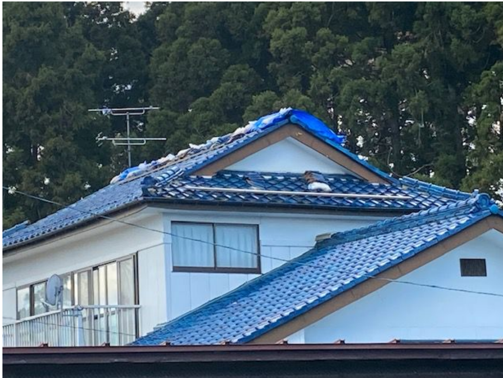
ブルーシート施工状況
