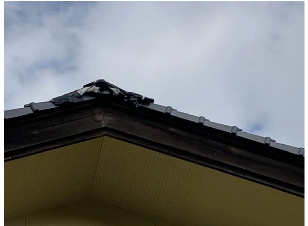
防水テープ施工状況
