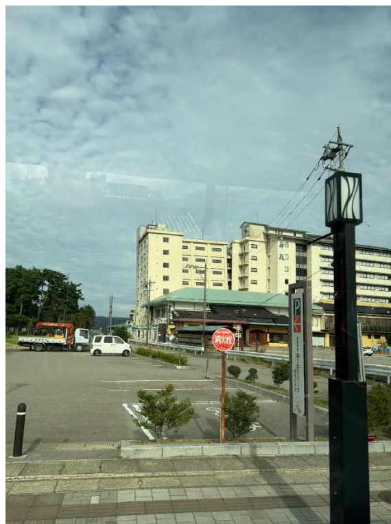
宿泊施設の破損は激しく、再建の道は険しいようだ
